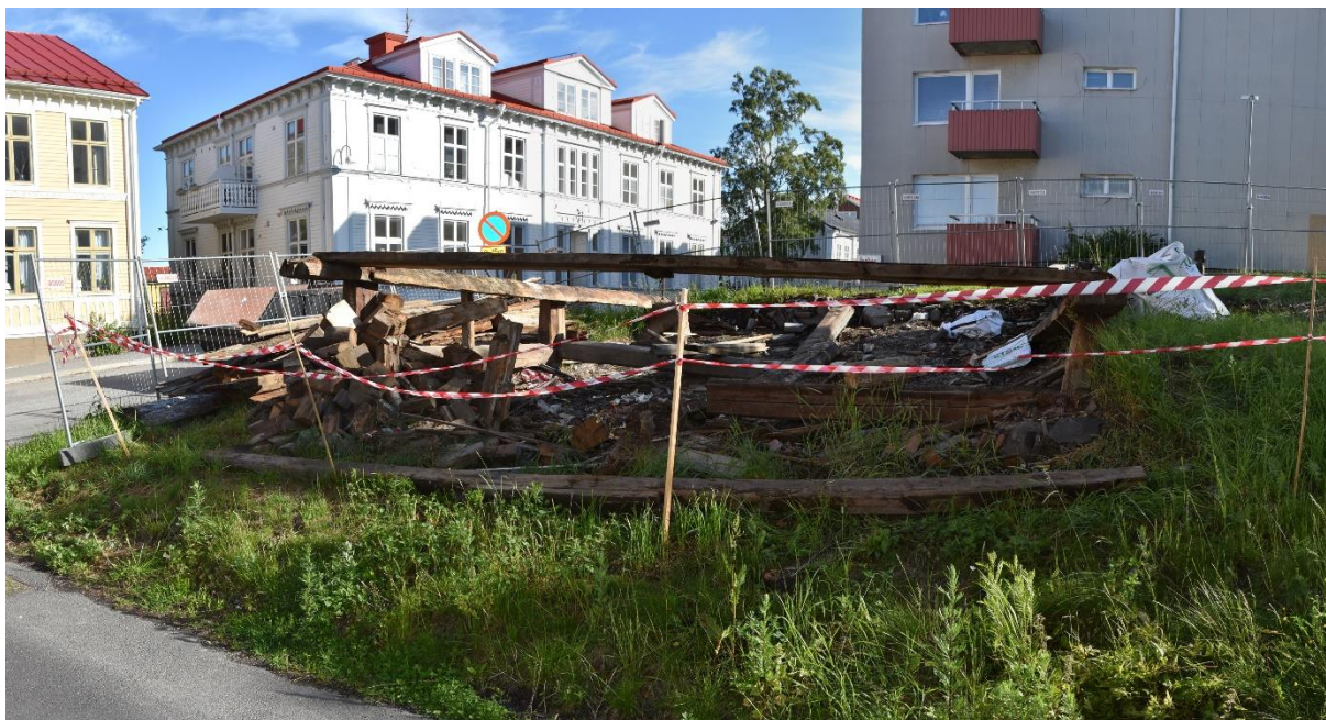
Figur 4. Undersökningsområdet från sydost. Området utgjordes av en kvadratisk grund till ett tidigare härbre. Runtom var en gräsbeväxt, öppen yta, svagt sluttande från öster ner mot sydväst. Cirka 15 meter öster om husgrunden stod ett befintligt härbre.
