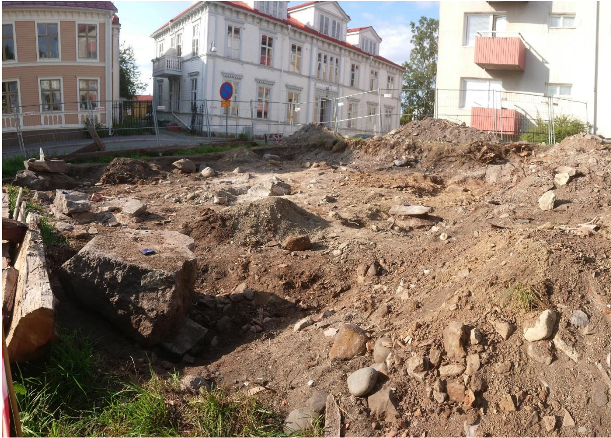
Figur 23. Översiktsbild över husytan tagen efter undersökningens avslutande då ytterligare rensning av ytan genomförts.
